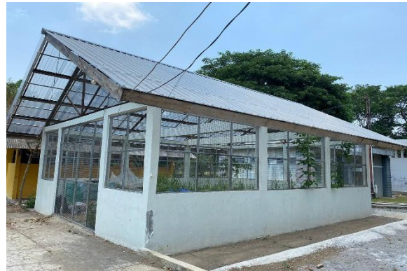
Gambar 28. Perbaikan Fasilitas rumah Kaca
