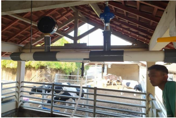
Gambar 35. Pemasangan Instalasi Alat Perah
