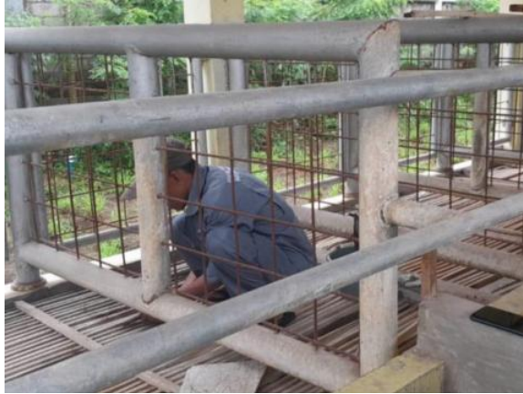
Gambar 29. Perbaikan lantai Kandang Kambing Perah
