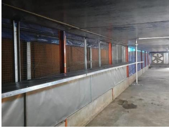
Gambar 35. Perbaikan inlet model combi-inlet
