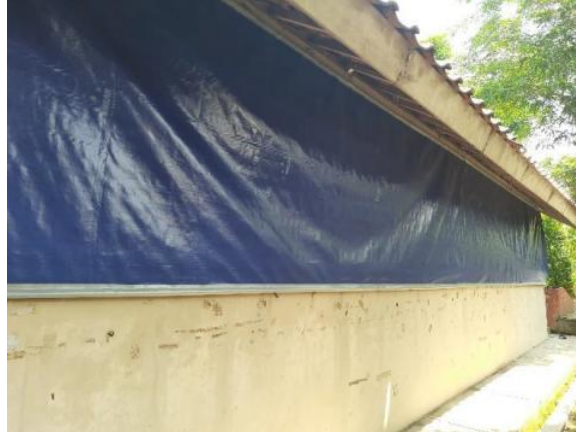
Gambar 26. Pemasangan tirai Kandang Open House
