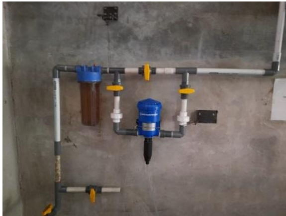
Gambar 34. Perbaikan instalasi medicator dosatron
