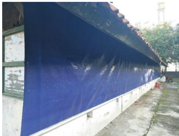
Gambar 28. Pemasangan tirai Kandang Open House Hijau
